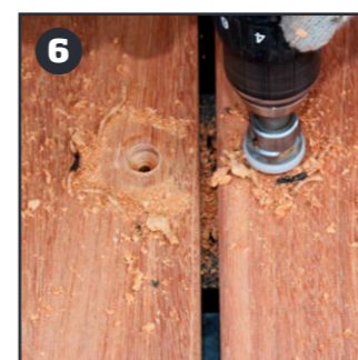
6 Forboring af huller til propper
