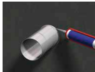
D6. Fuging rundt gjennomføringer
